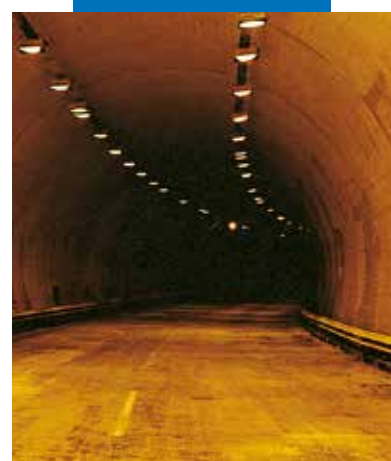
Planiseal 88 alb aplicat prin pulverizare intr-un tunel de autostrada
