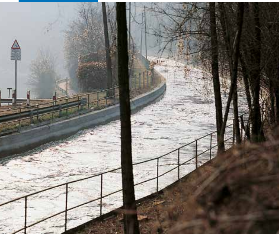
Canalul hidroelectric Bertini - Como, Italia. Suprafata a fost tratata cu Planiseal 88
