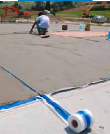
Hidroizolarea șapelor cu Mapelastic și Mapeband
