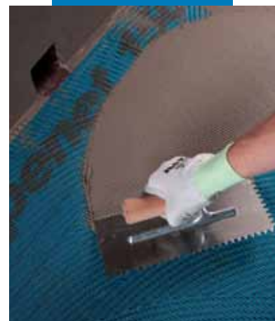
Aplicare Mapelastic pe Mapenet 150
