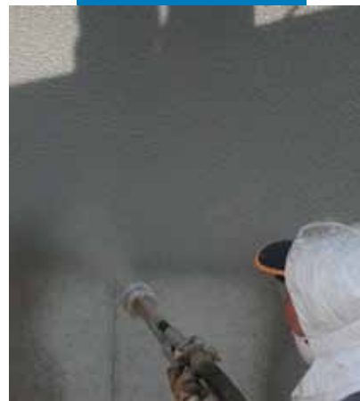
Exemplu de aplicare Mapelastic prin pulverizare la un viaduct
