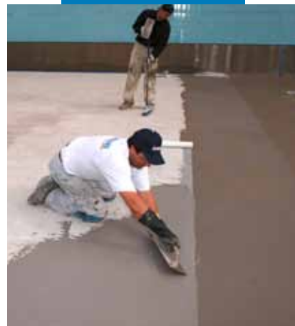
Hidroizolarea unei piscine cu Mapelastic
