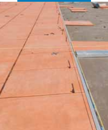
Instalarea plăcilor ceramice cu Kerabond + Isolastic
