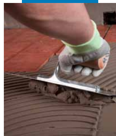
Aplicare Granirapid pe o terasă hidroizolată cu Mapelastic
