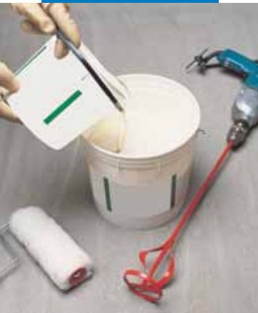
Amestecarea componentei B cu componenta A
