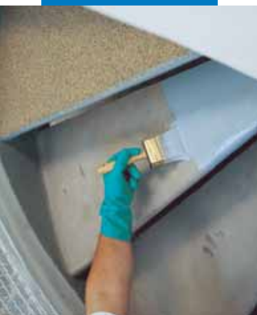
Aplicarea primului strat de Mapecoat I 24 pe beton
