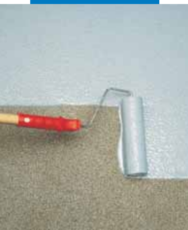
Aplicarea Mapecoat I 24 cu trafaletul
